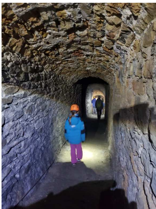
Souterrain du fort de Vaise
